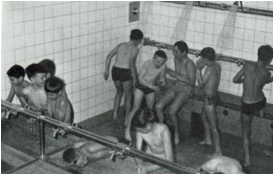
Das neue Duschbad der Schiller-Turnhalle
